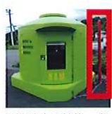
漂流防止用鉄柱工事 (鉄柱長さ3m + ステンレスチェーン)
